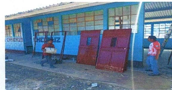
Foto 5: SUSTITUCIÓN DE PUERTAS DE METAL
