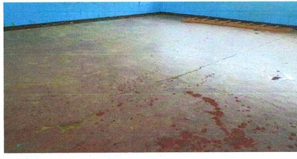
Foto 4: SUSTITUCIÓN DE PUISO
