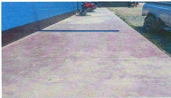
Foto 3: SUSTITUCIÓN DE PISO
