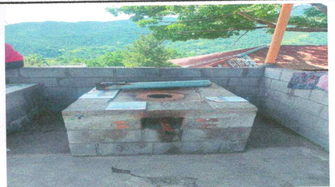
Foto 4: MEJORAMIENTO DE MURO PARA COCINA
