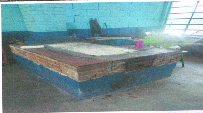
Foto 3: SUSTITUCION DE CERAMICO PARA ESTUFA ( AZULEJO )
