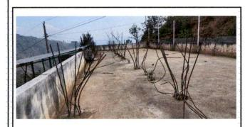
Foto 11: Losa del tercer nivel , lugar para colocar el deposito de agua.
