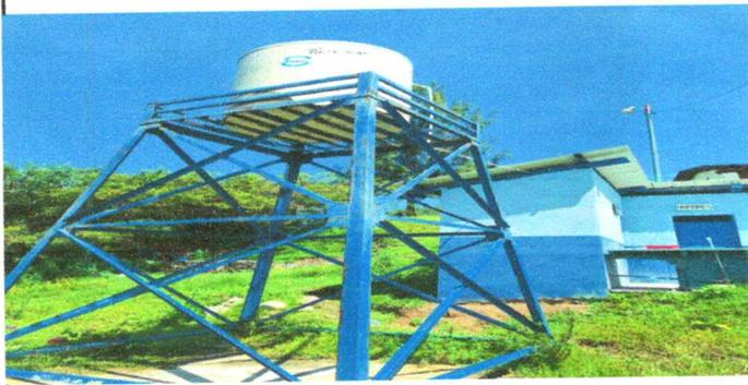
Foto 1: Mantenimiento de la base del tinaco y sustitución de accesorios depósito de agua
