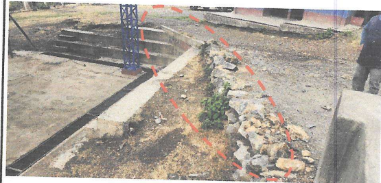
Foto 2: Se levantará pared para muro perimetral.
