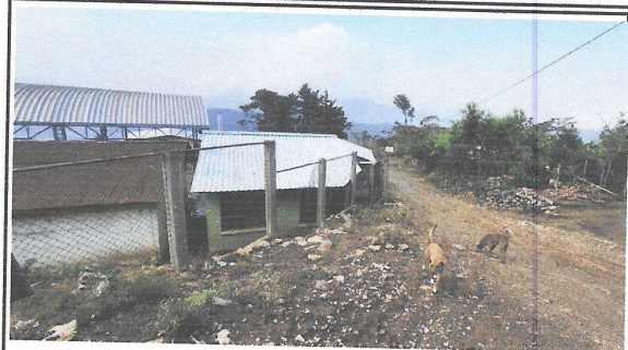
Foto 8: Vista del muro perimetral, en el cual se levantará pared con soleras de refuerzo.
