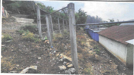
Foto 7: Vista del muro perimetral, en el cual se levantará pared con soleras de refuerzo.
