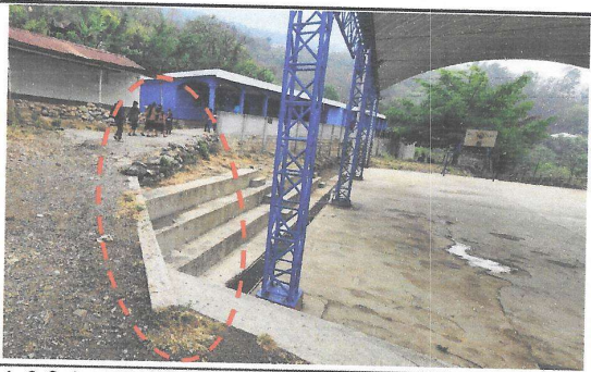
Foto 3: Se levantará pared para muro perimetral.
