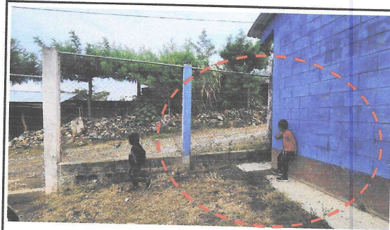
Foto 4: Se levantará pared para muro perimetral.
