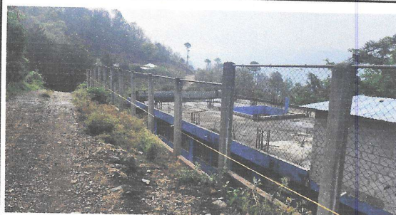
Foto 6: se levantara pared con muro de block y se colocaran soleras de refuerzo.
