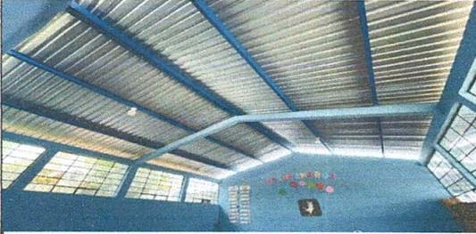
Foto 1: Techo de lamina cambiado y costaneras.
