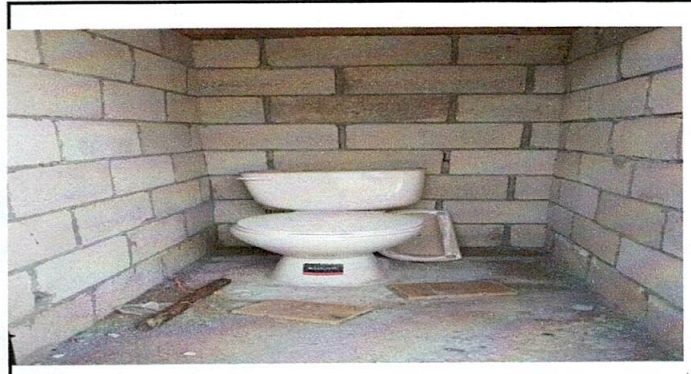
Foto 2: Instalación de inodoros
