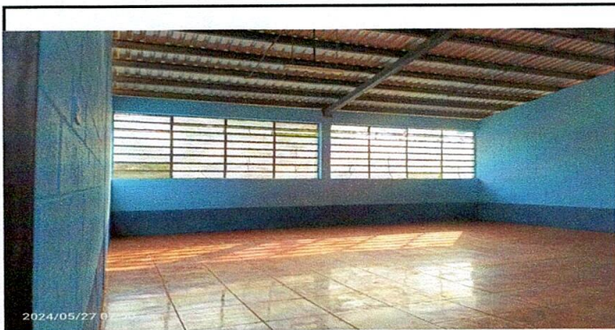
Foto 3: Instalación de piso cerámico.
