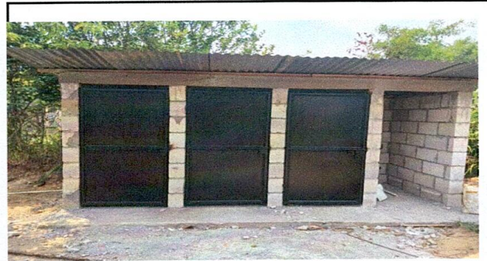
Foto 4 : Instalacion de puertas.
