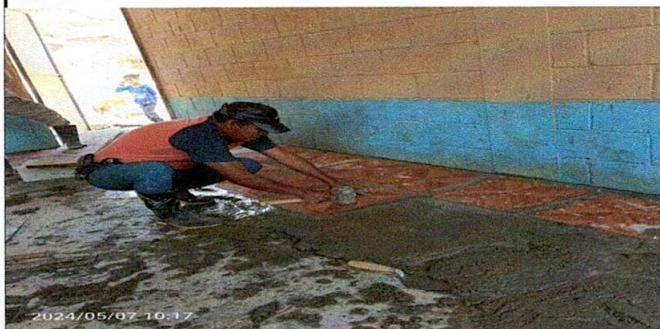
Foto 3: Instalación de piso cerámico.
