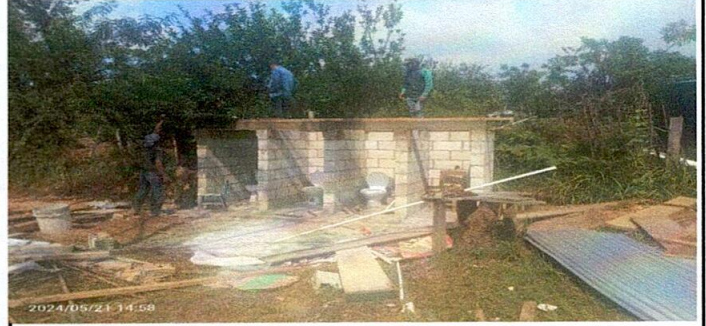
Foto 2: Instalación de inodoros
