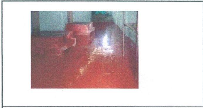
Foto 6: Reparacion de cemento liquido
