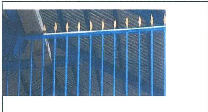
Foto 2: mantenimiento de portones
