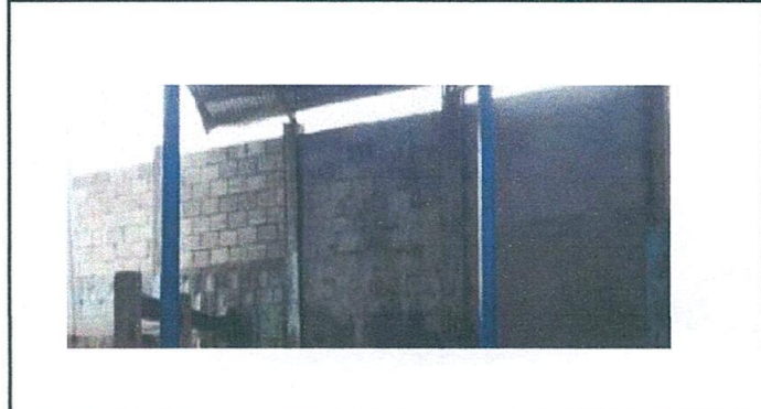
Foto 4: Sustitución y colocación de muro
