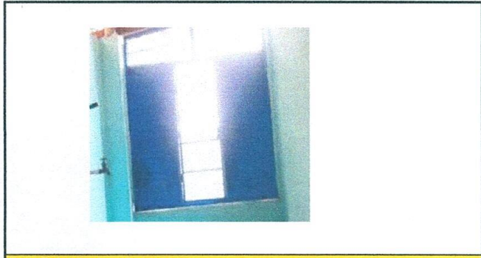
Foto 5: Instalacion de ventanas
