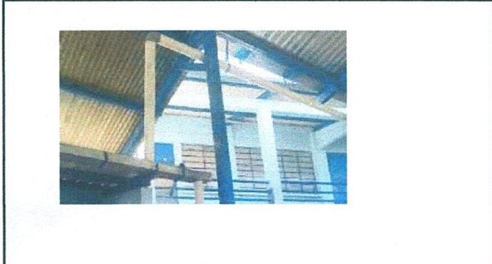
Foto 3: cambio de tubería
