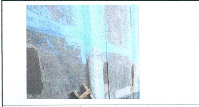
Foto 5: mejoramiento acabado en muro
