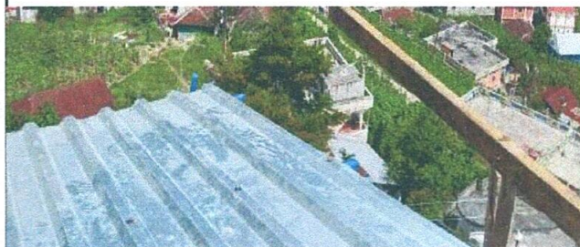
Foto 2: sustitucion de lamina troquelada
