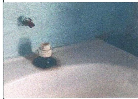
Foto 6: sustitucion de llave de chorro.
