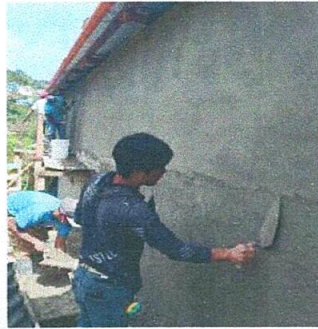
Foto 5: mejoramiento acabado en muro
