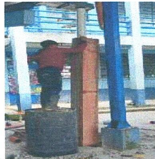
Foto 4: raparacion de bajada pluvial
