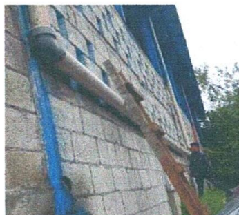
Foto 6: sustitucion tuberia de aguas negras
