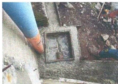
Foto 5: mantenimiento de cajas de registro
