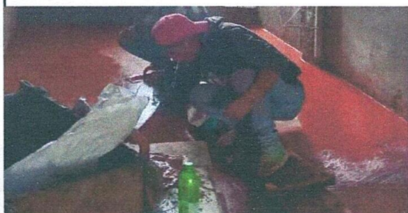
Foto 3: reparacion de de piso de cemento liquido
