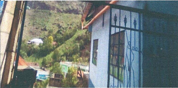
Foto 3: Mantenimientos a portones de metal
