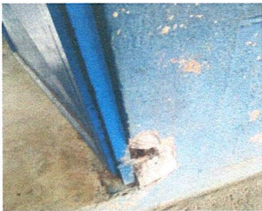
Foto 3: mantenimiento a estructura lijado, cambio de tubo.
