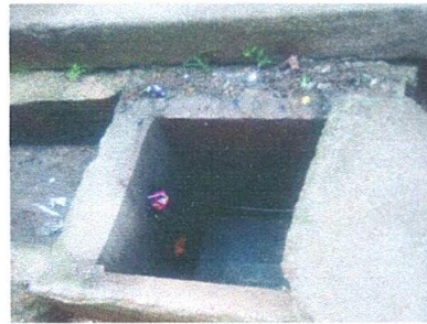
Foto 4: Mantenimiento a cajas de rejistro.
