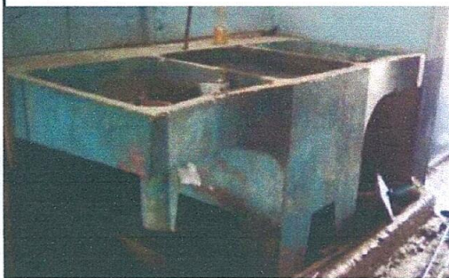
Foto 3: Sustitución de pila de cemento de dos lavadero
