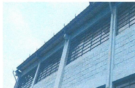
Foto 6: Sustitución de canal de metal.
