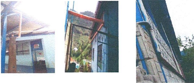
Foto1: Reparación de bajada de agua pluvial, tubo PVC 4.
