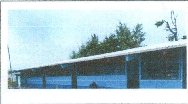
Foto1: Cubierta de lamina
