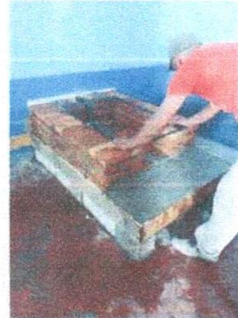
Foto 2: REPARACION DE COCINA
