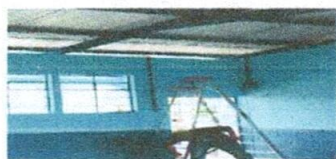
Foto 5: Pintura de paredes interior y exterior
