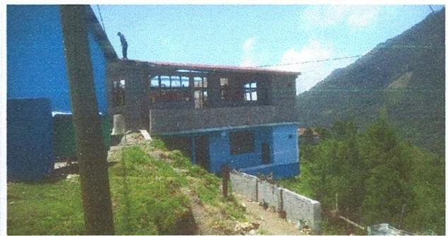
Foto 2: Finalización de la colocación de techo laminas troqueladas calibre 26 color rojo.
