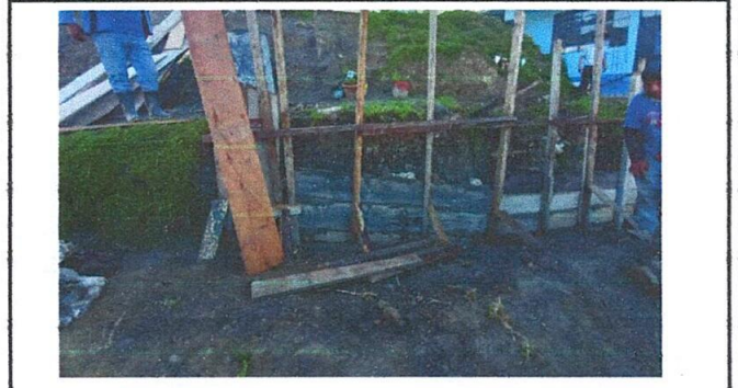
Foto 2: Inicio e colocación de muro de contención.
