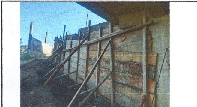
Foto 3: Mejoramiento de muro de contención.
