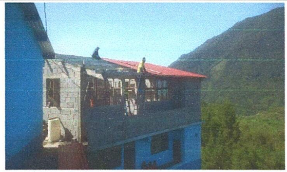
Foto 2: Colocación y mejoramiento de techo lamina troquelada calibre 26 color rojo.
