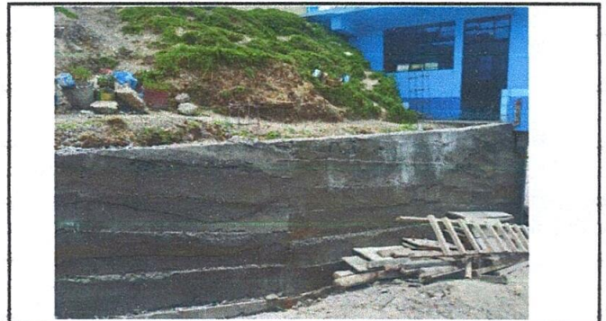
Foto 4: Sustitución y colocación de muro de contención en la entrada del aula.
