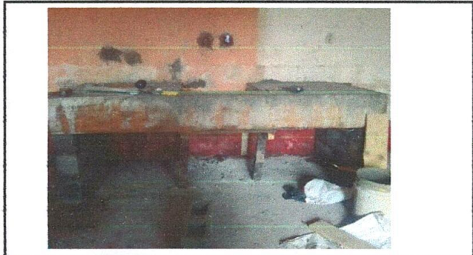
Foto 2: Mejoramiento de lavatrastos.
