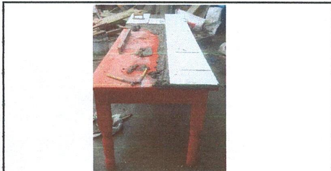
Foto 5: Colocación de piso ceramica en mueble de la cocina.
