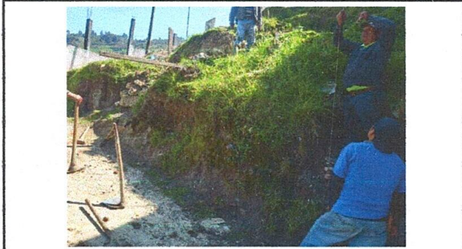
Foto1: Colocación de muro de contención.
