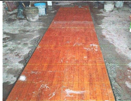
Foto 6: colocación de piso ceramica en la cocina.
