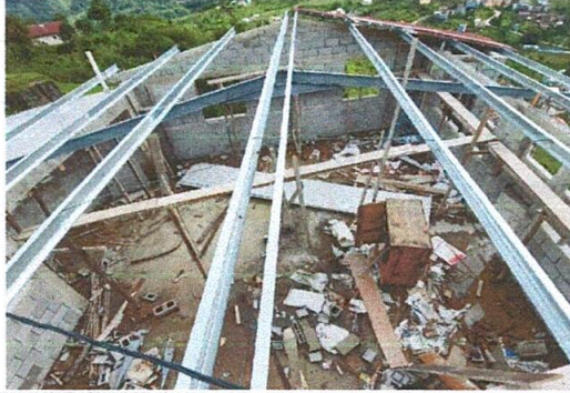
Foto1: Colocación y mejoramiento de estructura de sostenimiento de techo.
