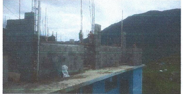
Foto 4: mejoramiento de techo lamina troquelada calibre 26
