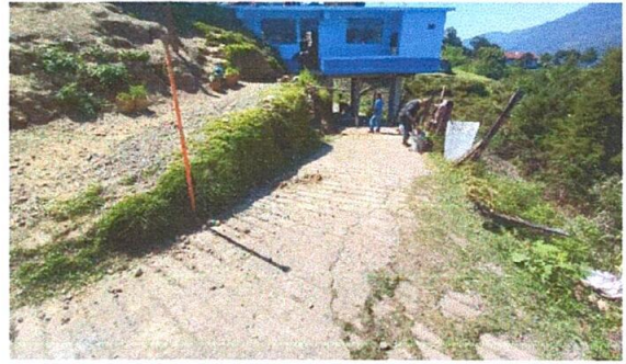
Foto 2: Colocacion de muro de contención y mejoramiento de calle de acceso del centro educativo.
