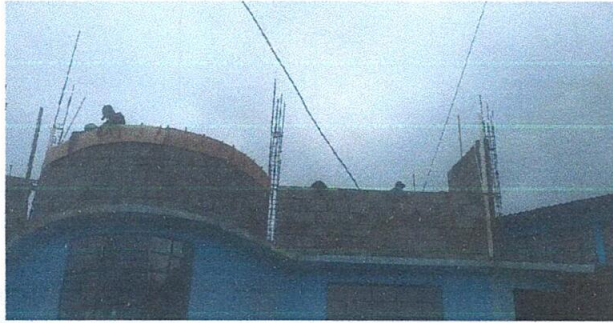
Foto 1: Mejoramiento de estructura de sostenimiento de techo.
