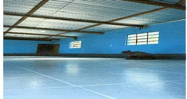
Foto 2: Colocación de piso de cerámica en aula que solo tenia torta de cemento.
