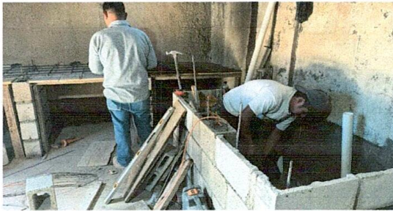
Foto 3: La pila se encuentra quebrada y rajada por lo que no permite almacenamiento de agua.
