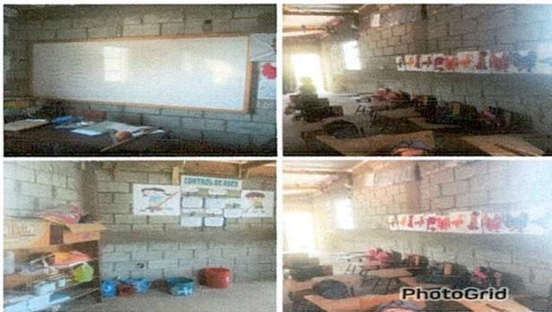
Foto 9: las paredes necesitan repello para evitar filtracion y humedad.
