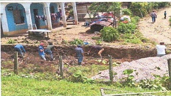
Foto 3: Se puede apreciar avance y remodelacion del muro perimetral con tubo hg y malla galvanizada, soleras intermedias y columnas.
