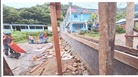
Foto 4: Se aprecia el trabajo que se está realizando en la reparación de muro perimetral con tubo hg y malla galvanizada, soleras intermedias y columnas.
