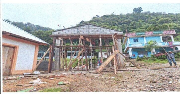
Foto 2: Se observa el acceso principal al MODULO 1. De la EORM, Aldea Yalambolop en remodelación
