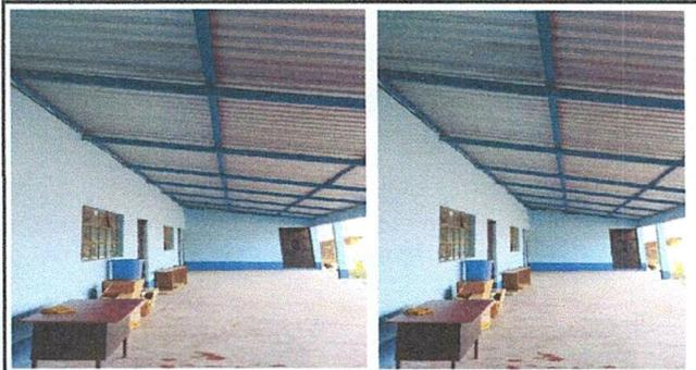
foto 5. sustitución de láminas del corredor
