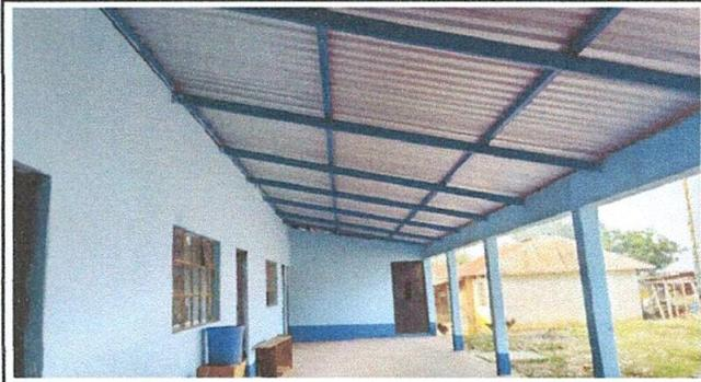
foto 2 sustitución de láminas externos
