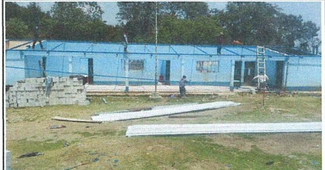
foto 4. sustitución de láminas en una de las aulas
