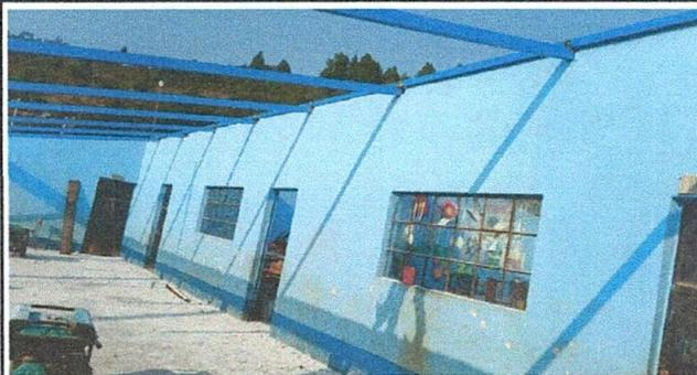
foto 5. sustitución de láminas del corredor
