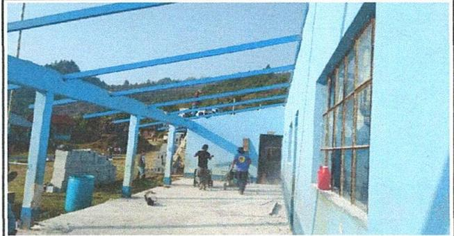
foto 2 sustitución de láminas externos
