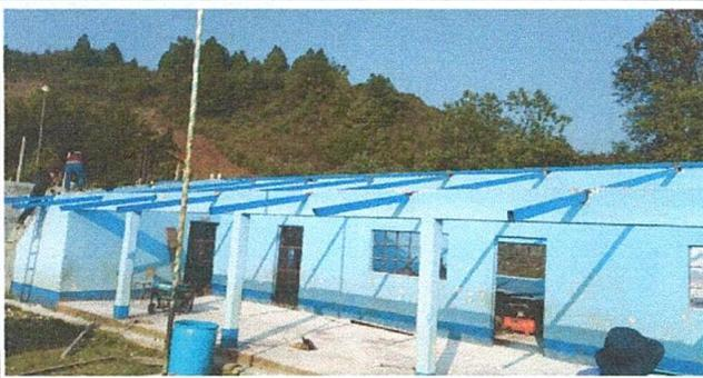
Foto 1: Sustrucción de lamina por lamina
