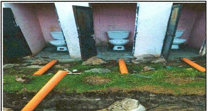
Foto 4: sustitucion de azulejos para baños
