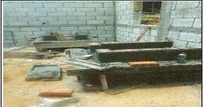
Foto 2: sustitucion de estufa rural
