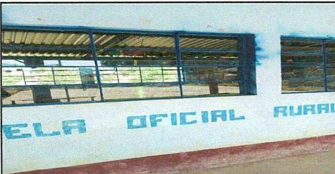
Foto 5: Aplicación de pintura
