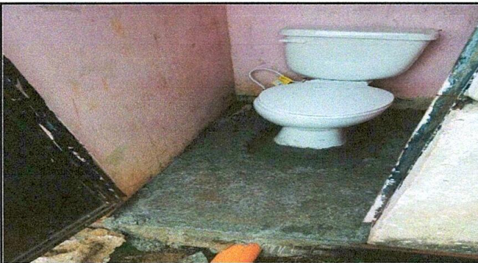
Foto 3: sustitucion de tasa inodoro
