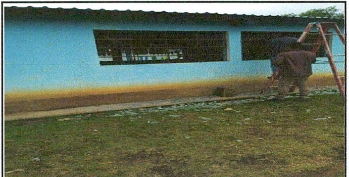
Foto 6: sustitucion de balcones
