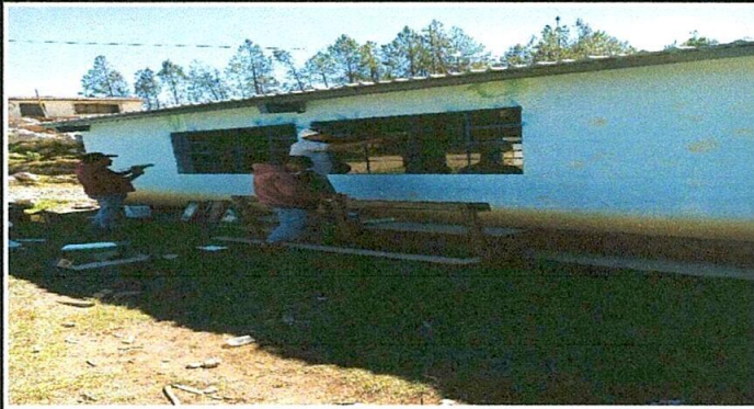
Foto1: sustitucion de ventanas
