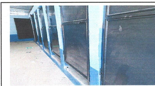
3. En la imagen se observa que se cambió en su totalidad las puertas tanto de lado de los baños que corresponden a hombres y de las mujeres que son en total once puertas.
