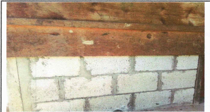
Foto 1: Mejoramiento paredes de cocina
