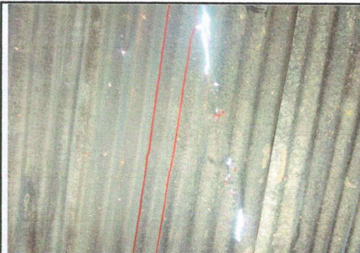
Foto 2: Mejoramiento de cubierta de lamina y estructura de techo
