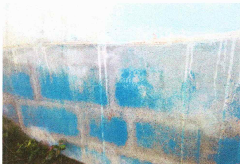
Foto 7: Reparación de pinturas en muros exteriores e interiores
