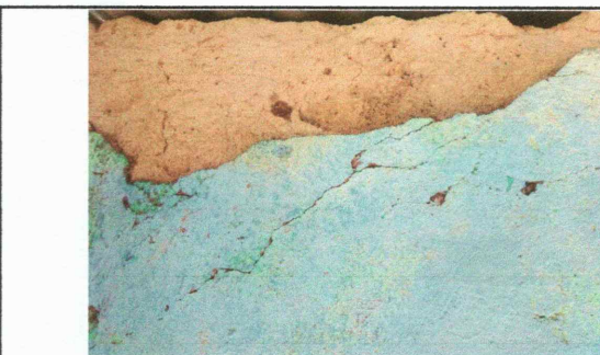
Foto 6: Reparación de repello en muro
