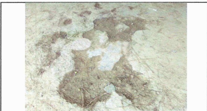
Foto 3: Reparación de losa de patio
