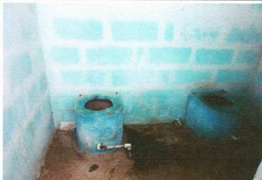
Foto 8: Sustitución de inodoro.
