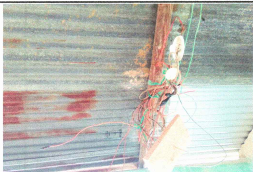
Foto 11: Reparación de cableado eléctrico
