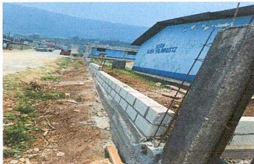
Foto 5: calle principal listo para la colocación del tubo hg y construccion de muro de concreto en cada desnivel
