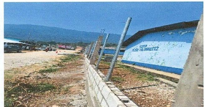
Foto 6: momento en donde pusieron los postes de hg y fundicion de muros de concreto en cada desnivel
