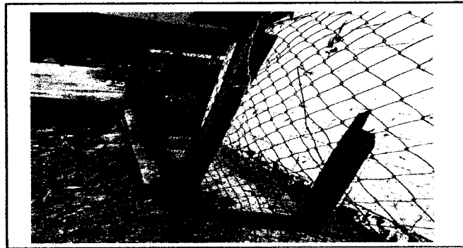
Foto 5: muro para base de malla y malla en mal estado
