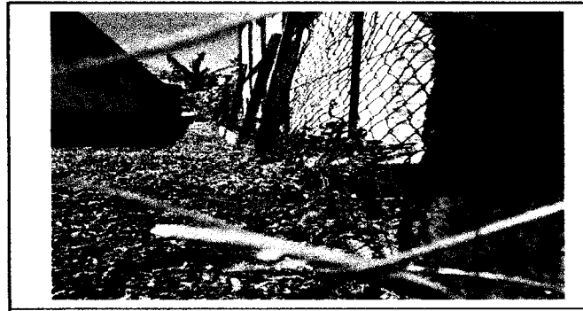
Foto 6: malla y postes en mal estado, y soleras de base deteriorado
