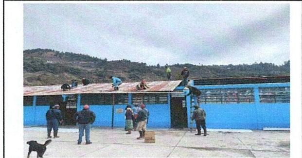
Foto1: Cambio de techo por el deterioro de láminas cuando llueve caen goteras.
