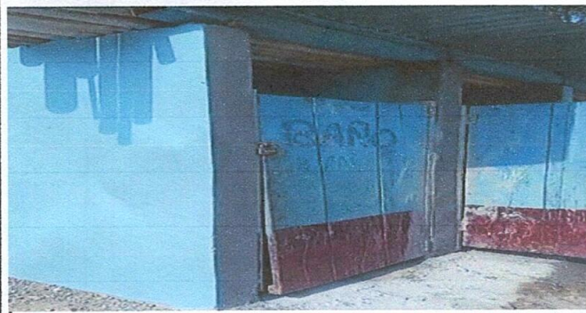
Foto 5: mantenimiento de paredes de baños
