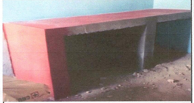
Foto 4: reparacion de cocina, construccion de mesa de concretos
