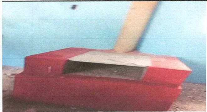
Foto 3: reparacion de cocina, construccion de nueva estufa e instalacion de chimenea.
