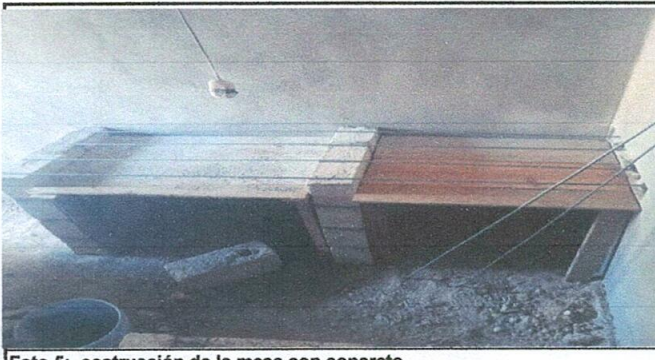
Foto 5: construcción de la mesa con concreto
