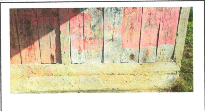
Foto1: Mejoramiento paredes de cocina de madera a block
