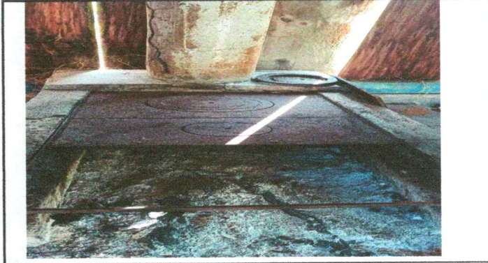
Foto 2: sustitucion de plancha y chimenea
