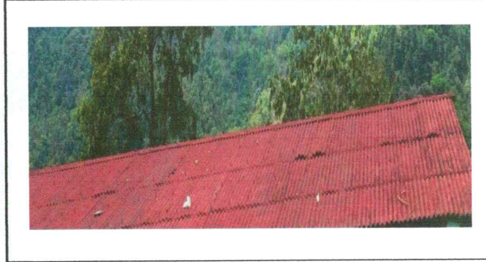
Foto 4: sustitucion de techo de la escuela
