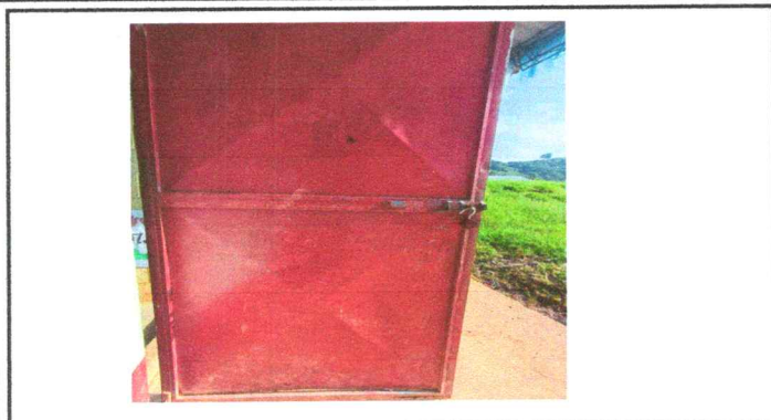
Foto 7: Mejoramiento de puertas
