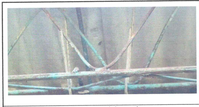
Foto 5: matenimientos de la estructura de la escuela
