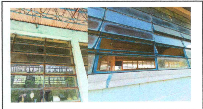
Foto 8: Mejoramiento de vidrios
