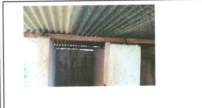
Foto 9: Sustitución de estructura de soporte de techo
