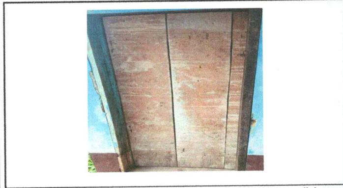
Foto 3: Sustitucion de puerta de la cocina que está en malas condiciones
