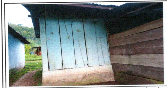
Foto 5: Mejoramiento de pared de madera por Block, es necesario mejorar las condiciones donde se preparan los alimentos de nuestros estudiantes ,eso influye en el aspecto social del proceso educativo.
