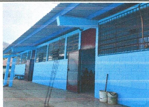
Foto 4: Mantenimiento de pared finalizado (exterior)
