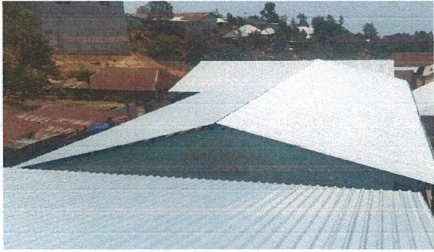
Foto 1: Sustitución de láminas finalizadas en las 6 aulas.
