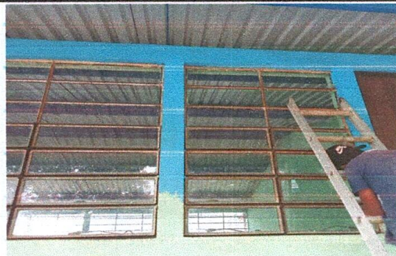
Foto 4: Pintando las paredes
