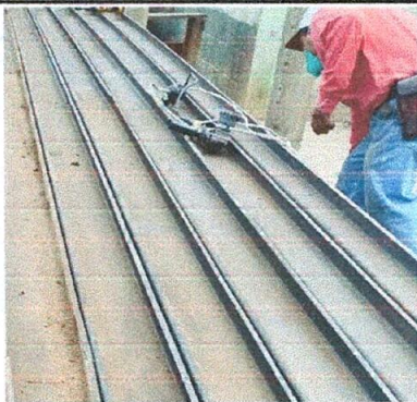
Foto 3: Mantenimiento a puertas y costaneras
