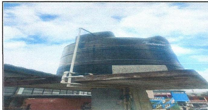
Foto 11: REPARACION Y MANTENIMIENTO DE CISTERNAS: Sustitución de deposito de agua, tinaco.
