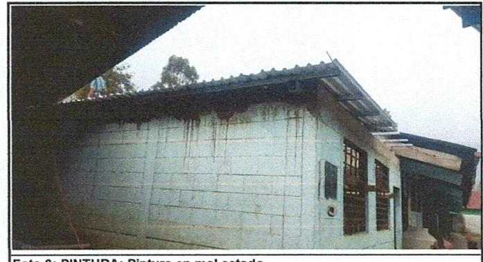
Foto 6: PINTURA: Pintura en mal estado.
