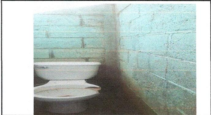
Foto7: SERVICIOS SANITARIOS Y SUS ACCESORIOS. Cambio de tazas por estar en mal estado.
