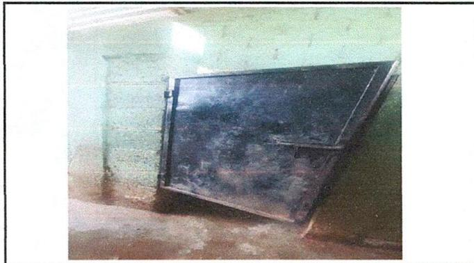
Foto 3: PUERTA DE METALI: Sustitución de puertas de metal ya que se encuentran en mal estado y es necesario cambiarlas.
