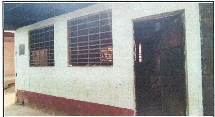
Foto 4: VENTANAS: sustitución de estructura de metal de ventana ya que se encuentran deterioradas.
