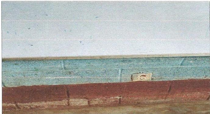
Foto 9: REPARACIÓN DE SISTEMA ELÉCTRICO: Es necesario el cambio de tomacorrientes por que representan un peligro para los niños.
