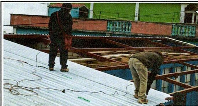
Foto 3: Instalando el lamina de los aulas
