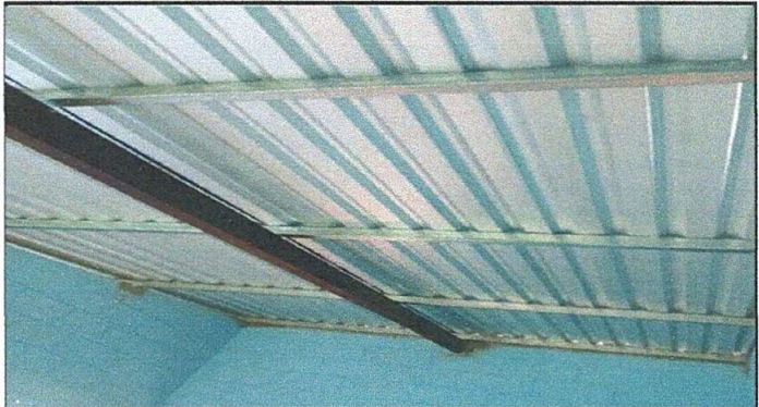
Foto 4: Laminas instaladas y costaneras
