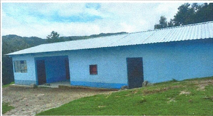
Foto1: Así se quedó la cocina y la escuela pintada
