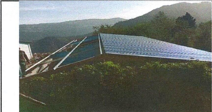
Foto 2: Se ve la instalación de nuevas láminas
