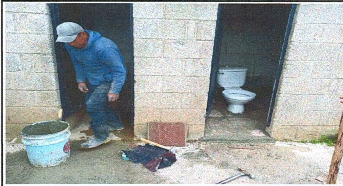
Foto 4: Instalación de las tazas de inodoro
