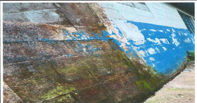
Foto 12: pintura muros exteriores
