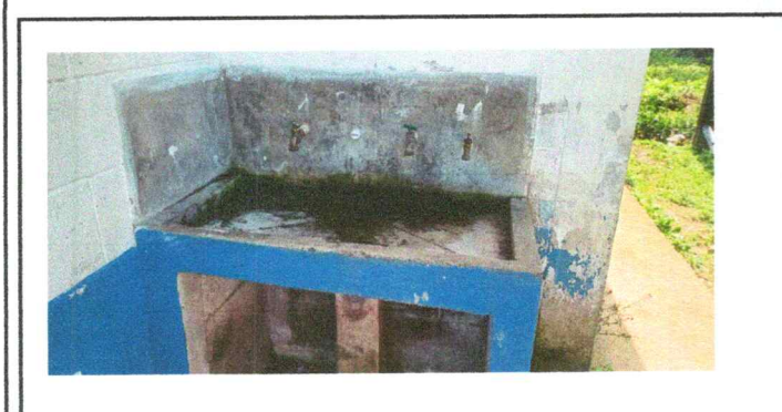
Foto 5: Sustitución de lavamanos en mal estado
