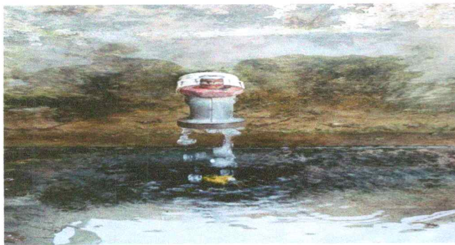
Foto 9: Sustitución de llaves de agua en malas condiciones
