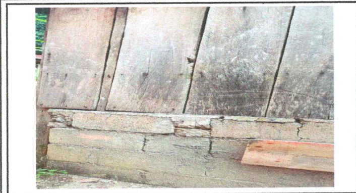
Foto1: Mejoramiento paredes de cocina
