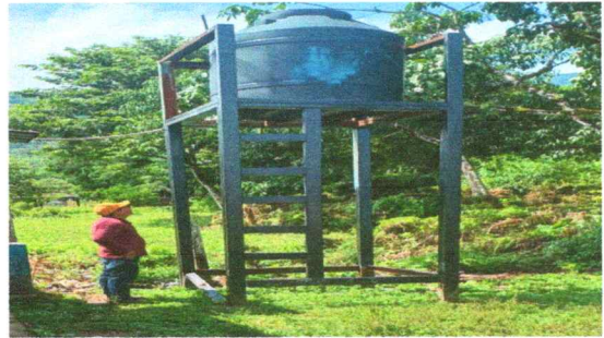
Foto 8: Reparación de base de soporte para tanque de almacenamiento de agua
