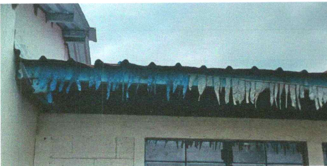
Foto 11: Sustitución de cubierta de laminas de aulas
