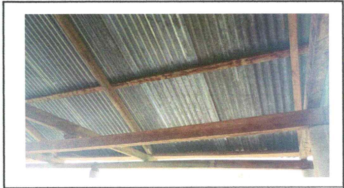
Foto 2: Sustitución de cubierta de Lámina y estructura de techo
