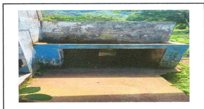
Foto 6: Reparación de losa de patio en malas condiciones
