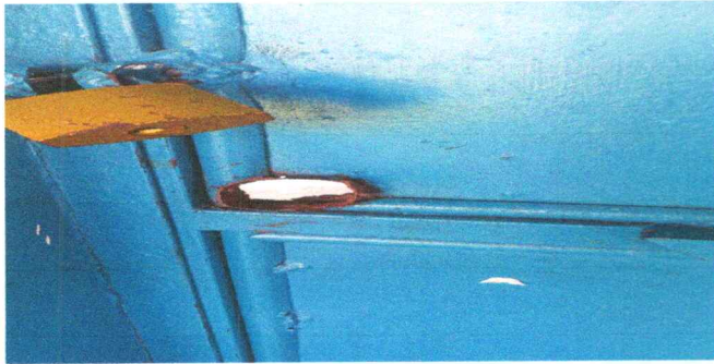
Foto7: Sustitución de chapas de puertas en malas condiciones
