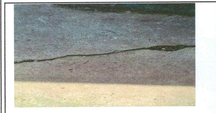
Foto 3: Reparación de piso de torta de cemento en malas condiciones
