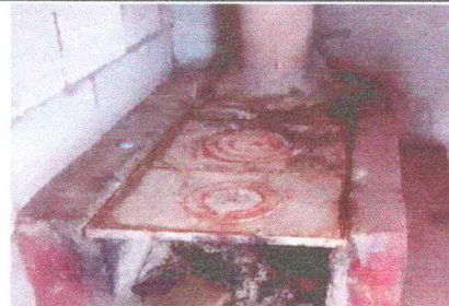
Foto 6: Sustitución de chimenea y plancha en mal estado
