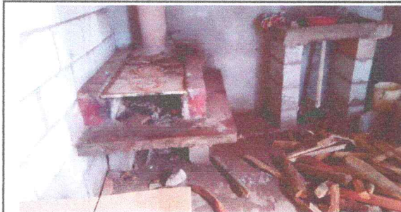
Foto 3: Sustitución de fogon en mal estado
