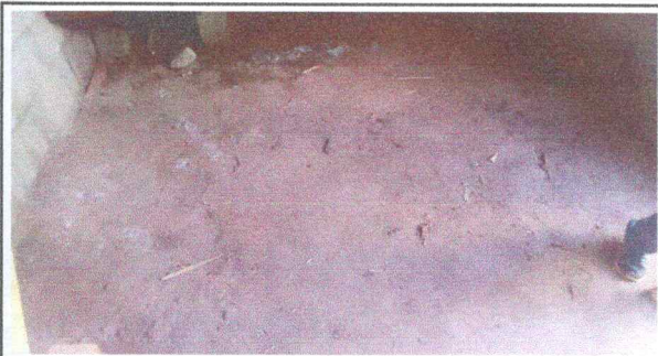
Foto 4: Sustitución de piso de granito dañado
