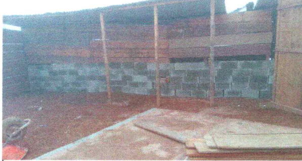
Foto 1: Mejoramiento de pared de madera a block en cocina
