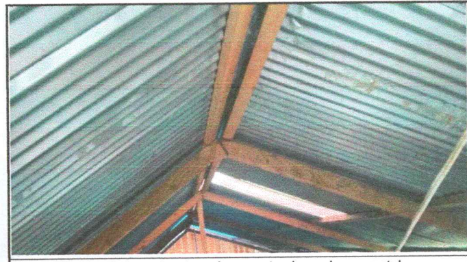
Foto 4: Sustitucion a estructura de soporte de madera a metal
