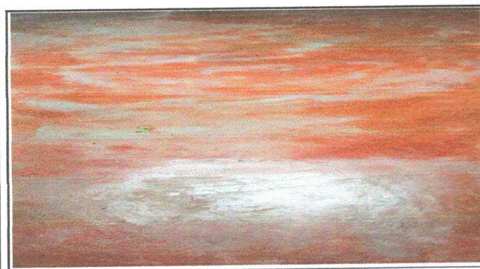
Foto 3: Sustitucion de piso de Cemento liquido
