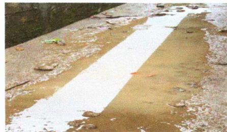
Foto 12: Reparación de cuneta en mal estado para que fluya el agua y evitar inundaciones.
