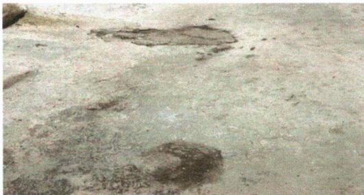
Foto 5: Piso de cemento en mal estado.
