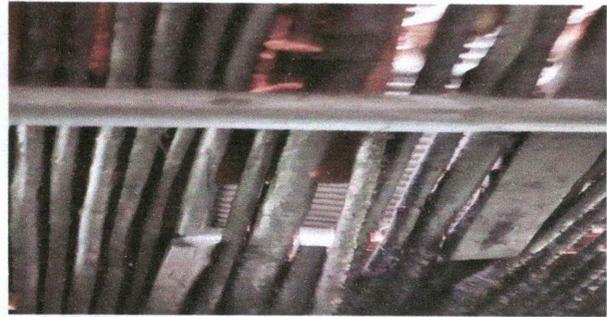
Foto 2: Cambio de madera de soprte de techo en mal estado, para una mejor estructura y evitar accidentes.
