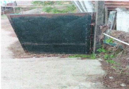
Foto 9: Fabricación e instalación de portón de metal de ingreso 175x2m.
