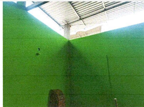
Foto 6: Pintado de paredes, finalizado
