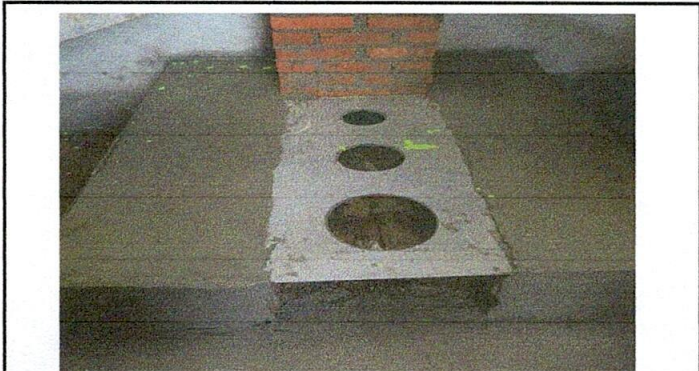
Foto 9: Sustitución de plancha de tres hornillas, finalizado.
