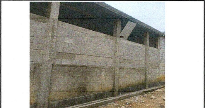
Foto 8: Reparación de paredes, finalizado
