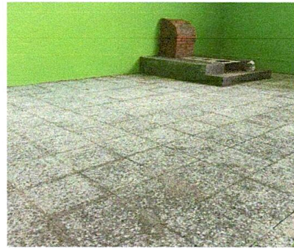
Foto 4: Reparación de piso de concreto, finalizado.
