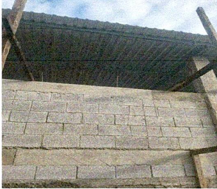
Foto 1: Cambio de lámina, por lámina troquelada aluzinc, finalizado.
