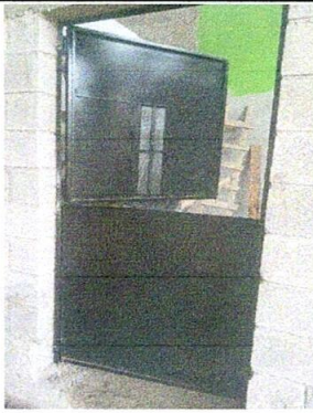
Foto 3: Sustitución de puertas, finalizado.
