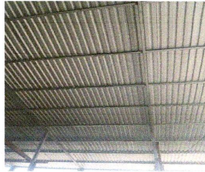
Foto 2: Cambio de estructura de techo de madera por metal, finalizado.
