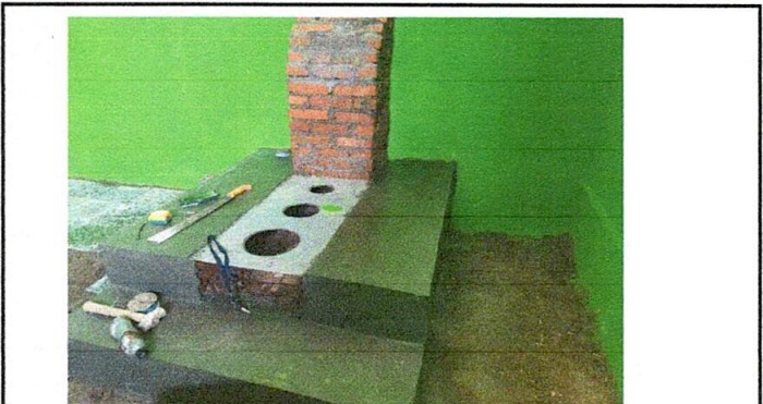
Foto 10: Reparación de chimenea de concreto, finalizado.
