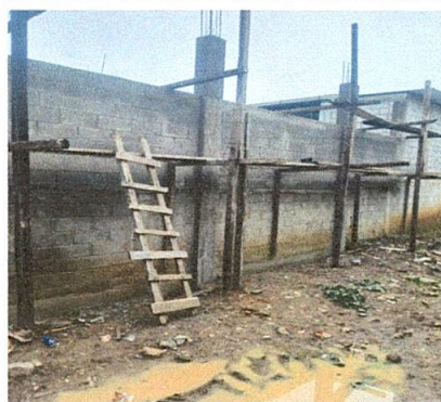
Foto 8: Se continuaron unas iladas mas de blok para dejar alto el techo.
