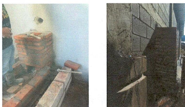
Foto 10: Debido al espacio se cambió la posición de la chimenea.
