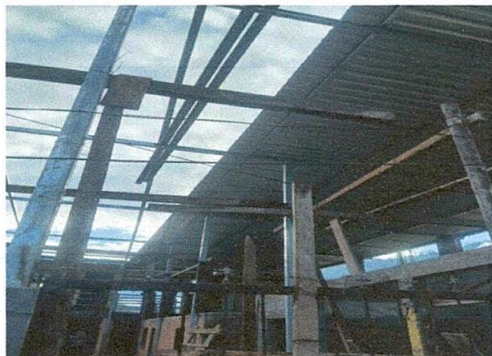
Foto1: Se está colocando las láminas en el techo.
