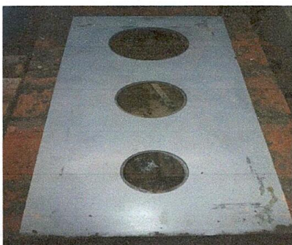
Foto 9: Se está colocando la nueva plancha.
