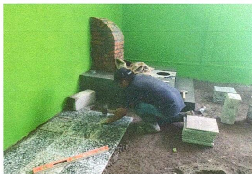
Foto 4: Se esta colocanco el piso de granito en la cocina.
