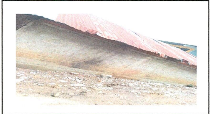
Foto 2: Es necesario continuar algunas iladas más de blok y colocarle corona de concreto a esta pared para que el techo quede más alto y de esa manera evitar que los carros pasen rozando la lámina.
