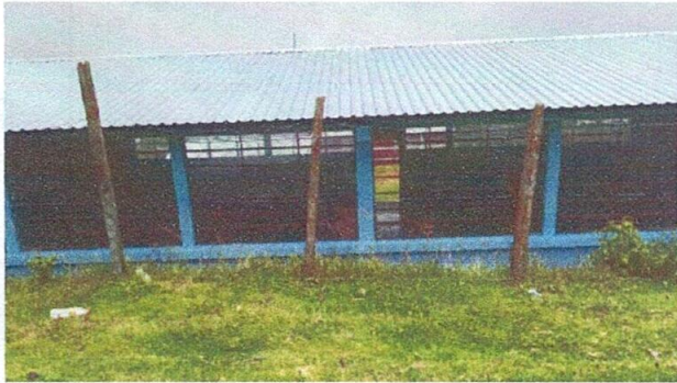
Foto1: Techado de laminas nuevas de la EORM, Palugua, aldea Bulej.
