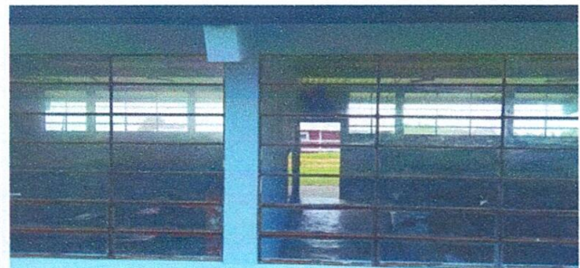
Foto 6: Mantenimiento de vidrios de ventanas.
