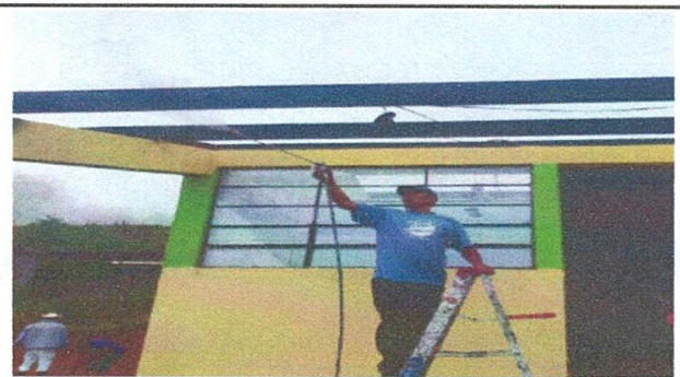
Foto 2: Mantenimiento en proceso de costaneras de cocina.
