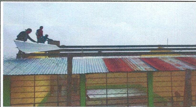
Foto1: Cambio de laminas del techado de la EORM, Palugua, aldea Bulej.
