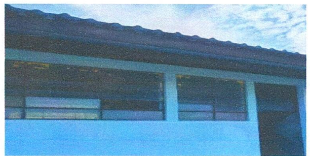
Foto 6: Cambio de vidrios rotos de ventanas.
