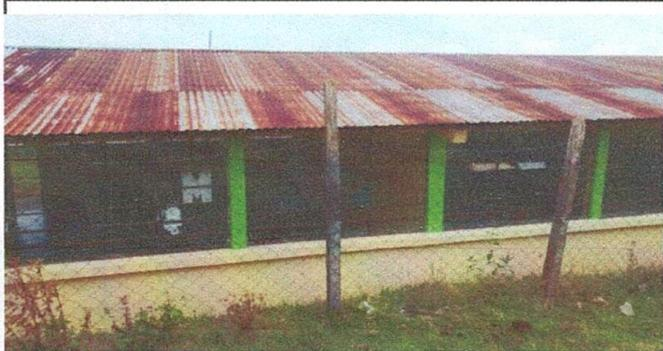
Foto1: Deterioro de laminas del techado de la EORM, Palugua, aldea Bulej.
