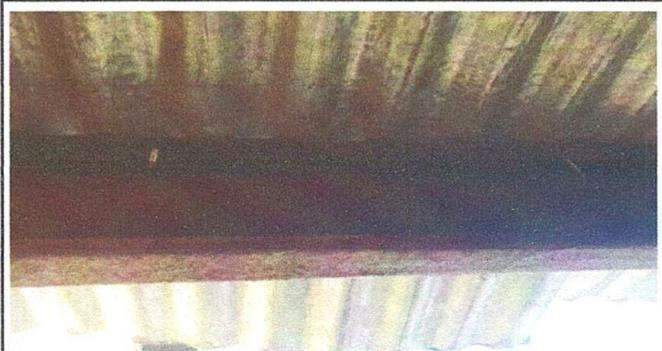
Foto 2: Deterioro y oxidación de costaneras de cocina.
