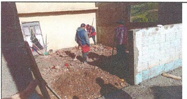
Foto 5: Proceso de sustitución de piso en mal estado, sustitución torta de concreto y piso de cemento liquido.
