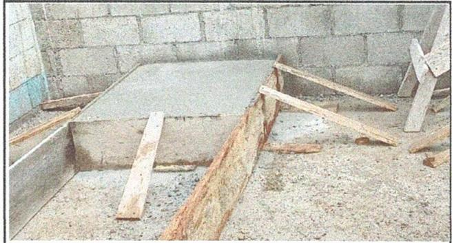
Foto 2: Elaboración de la base para la instalación de la pila, por lo que se sustituirá por otra pila nueva de dos lavaderos.
