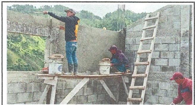
Foto 4: Proceso de mejoramiento de paredes y el repello correspondiente.
