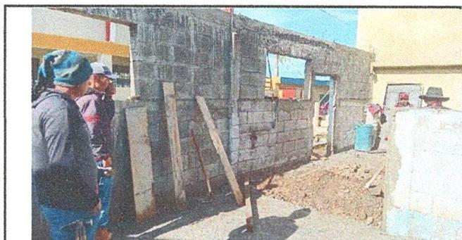
Foto 6: Proceso de ampliación de paredes y sustitución de laminas por vidrios de metal, como también la sustitución de puertas de metal por deterioro.
