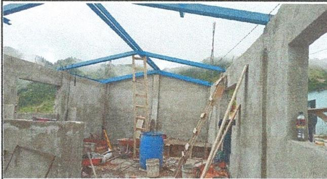
Foto 1: Proceso de instalación de techo en la cocina de la EORM aldea Yalanciop.
